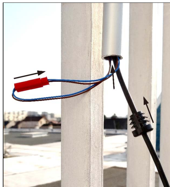
Figure 2-6 – Mise sous tension de l'anémomètre
