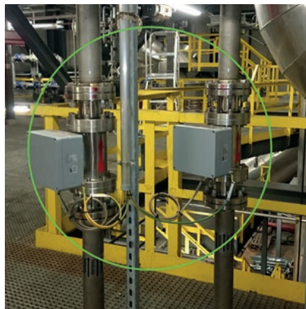
MESURE DE DÉBIT EN TRANSPORT PNEUMATIQUE
